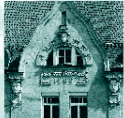
Platnersgarten an der Bucher Straße / Jugendstilfassade
