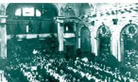
Historischer Festsaal des Parkhotels, Abriss 2013
