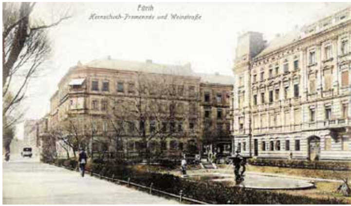
Parkanlage zwischen Hornschuchpromenade und Königswarterstraße, kolorierte Fotografie 1906
